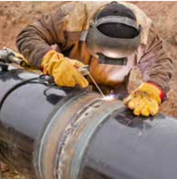
图12。手工电弧焊。
