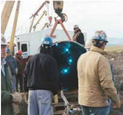
图14。气体保护电弧焊 (WestPATH, GR690内焊 使用 4头 短路融化极气保焊 [7])。
