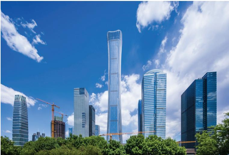
中信大厦，俗称中国尊大厦，是北京最高的建筑，高度为528米。本工程采用了高性能混凝土（HPC），28天的抗压强度从C50MPa到C70MPa。
