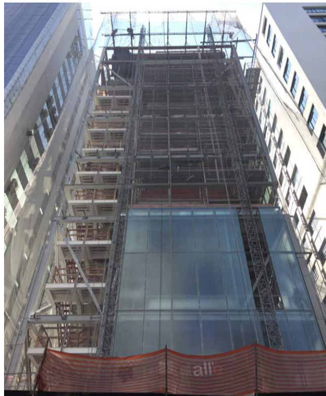
图 12 - 玻璃围护系统的组装
