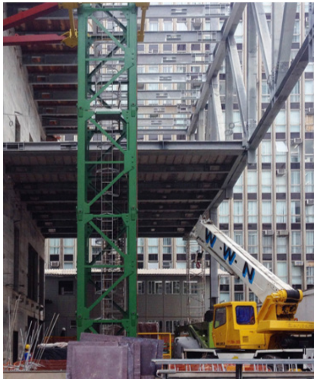
图 11 - 左侧：来自 GR60 钢材建造的展览楼层中一个楼层系统的热轧梁，配有网格开口以进行服务集成。右侧：组装起重机、一根定位巨型桁架和混凝土核心 图片来源：José Luiz Canal
