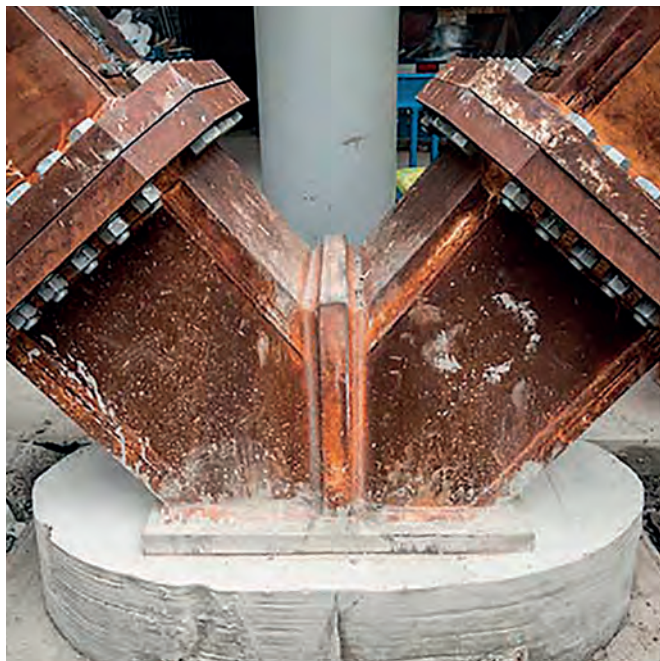
图4 V 形柱连接到地面重达 3 吨的节点（被混凝土包覆前） 资料来源：BCSA
