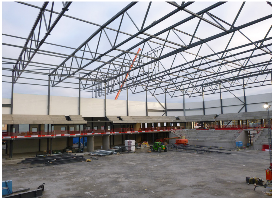
图5. 安装到位的主竞技场跨度52 m 的桁架。 图片来源：由Ruukki 提供
