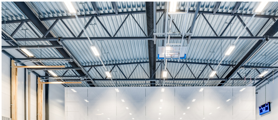
图 4 主竞技场柱子和屋盖桁架 图片来源：由Svante Lundbäck SE提供
