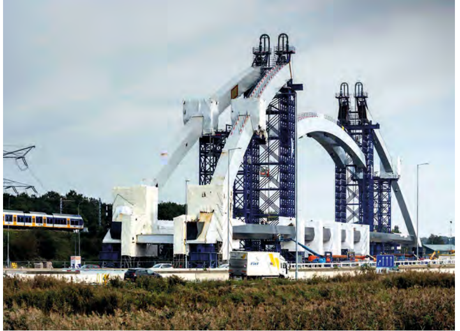
图4 使用钢绞线千斤顶组装拱形结构 资料来源：Iv-Infra b.v.
