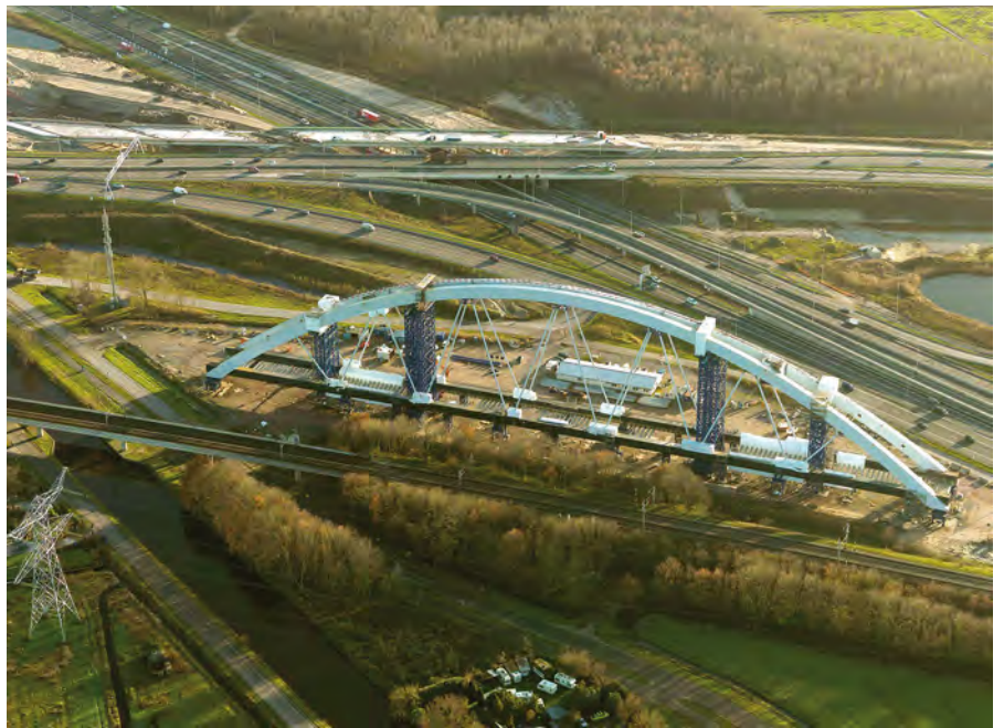
图5 在 A1 公路旁组装 Zandhazen 桥 资料来源：Rijkswaterstaat
