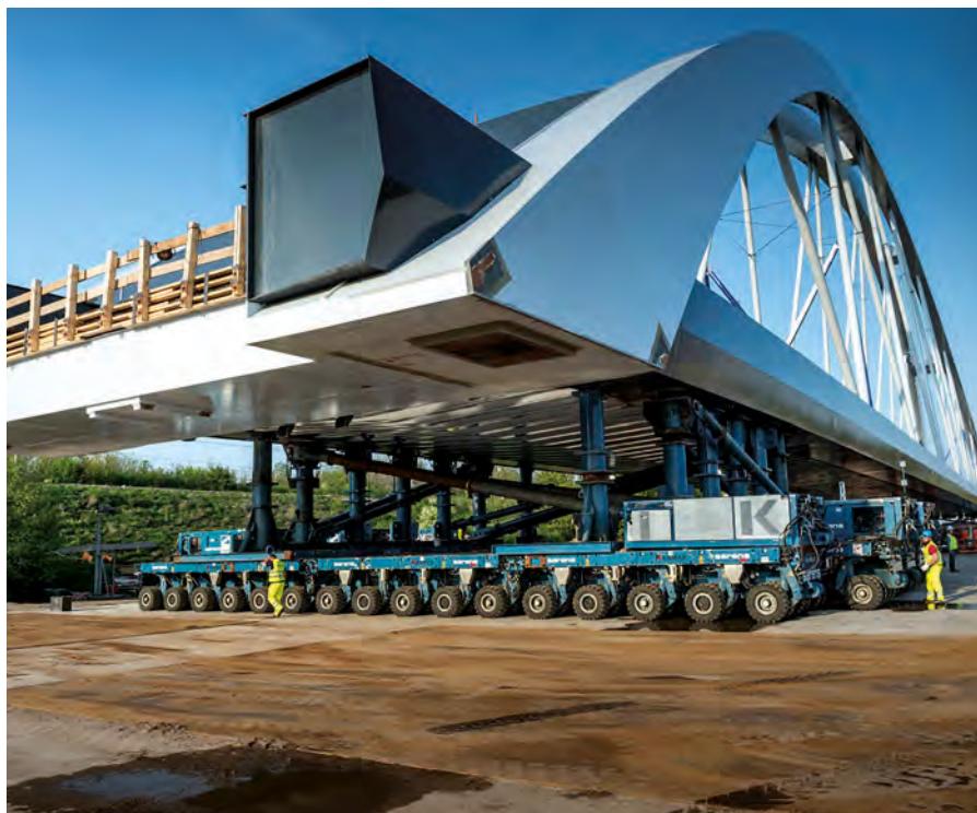
图7 使用自行式模块化平板车将桥梁移动到A1 上方 资料来源: Iv-Infra b. v
